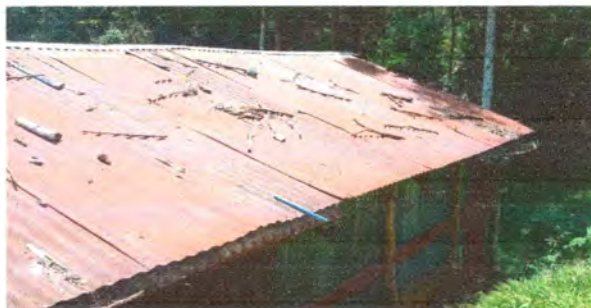
Foto 6: Canales y bajada de agua pluvial: Se sustituirán los canales de metal por canales cuadrados de metal.
