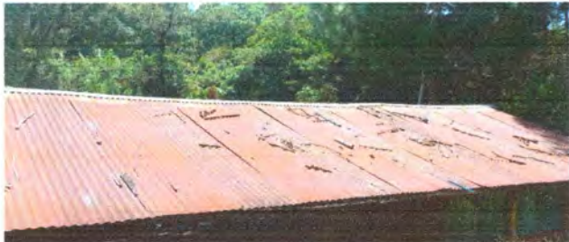
Foto 1: Cubierta de Láminas: Se sustituirán las láminas acanaladas por láminas troqueladas.
