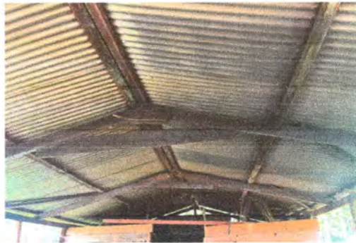
Foto 2: Estructura de techo (Sustitución de soporte de madera por metal): Se cambiarán las Vigas y costaneras de madera por metal.
