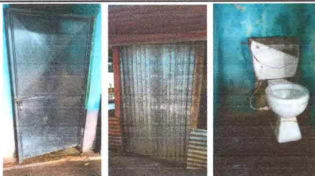
Foto 3: Puertas de metal (aulas y sanitarios): Se cambiará la puerta de lamina por puerta de metal para aulas, y se sustituirá la puerta de metal para baños, así como la sustitución de sanitarios blancos pequeños.
