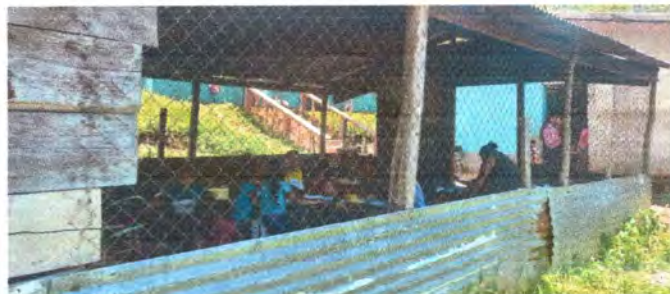
Foto 8: Mejoramiento pared de lámina y malla por Block (aula): Se sustituirán las paredes de malla y lámina por block.
